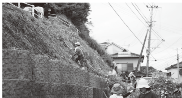
法面を手入れする松原区
