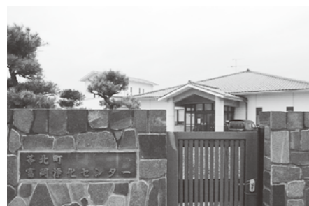
富岡浄化センター
