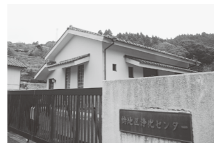
鶴地区浄化センター
