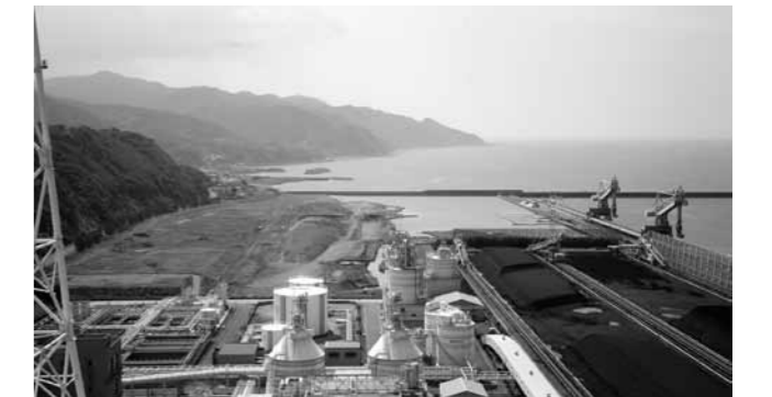
ボイラー建屋屋上からの眺め
