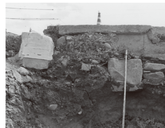
写真3 2個の大石(切り石)：道路直下に据わる
