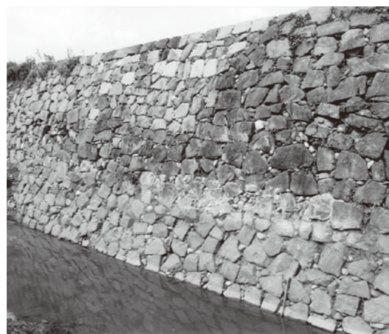
写真2-1 西側堀切：北壁は高さ8mの高石垣
