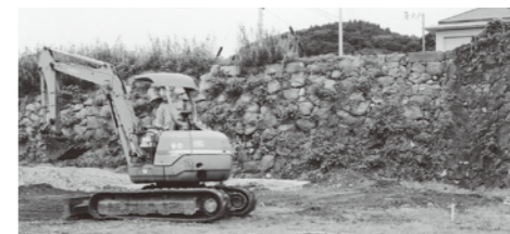
写真2-2 西側堀切調査前(平成26年7月)
