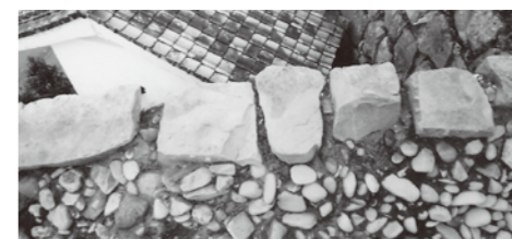
写真1 北隅櫓 南縁(天端石とグリ石)
