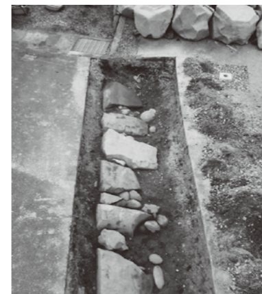
写真6 東側石垣：道路下の根石列
