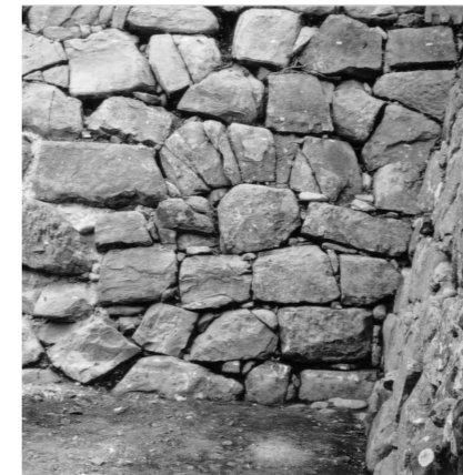
写真5 積み直し前の石垣
