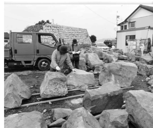
写真7 積み石の計測
