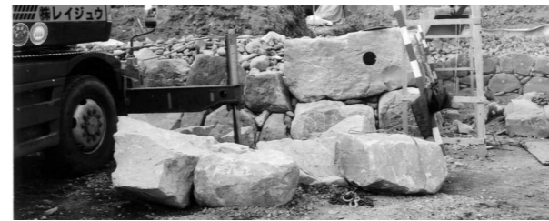
写真3 石垣の積み直し (●は、煎餅石に代えて新しい角隅石)
