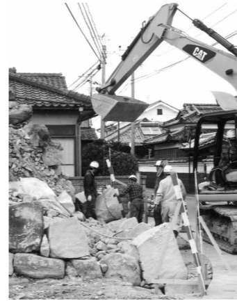
写真2 根石の据え付け
