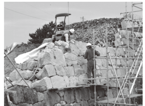
写真2 東側石垣の復元工事
