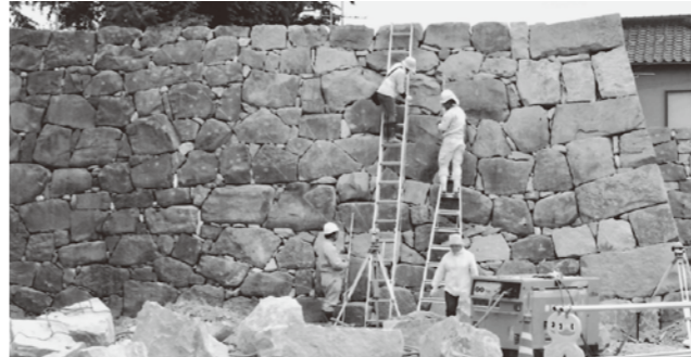
写真3 石垣Aの修復後の図化作業
