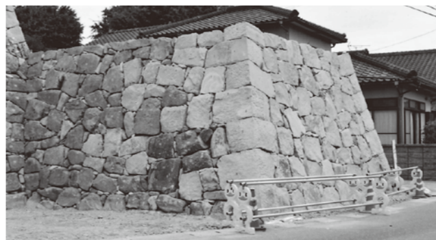
写真4 修復後の石垣Cと石垣D
