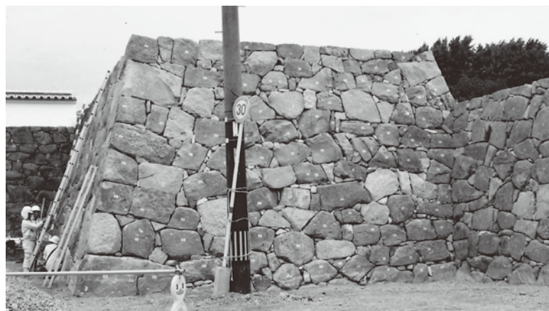
写真2 石垣B 修復後
