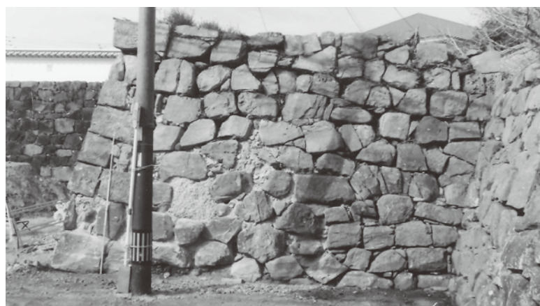
写真1 石垣B 修復前
