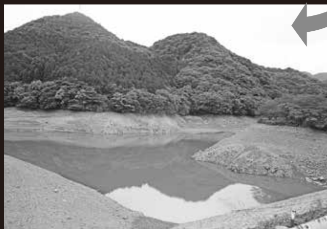
志岐ダム低水位時の写真 (R1.6.3撮影) ※貯水率11.3%
