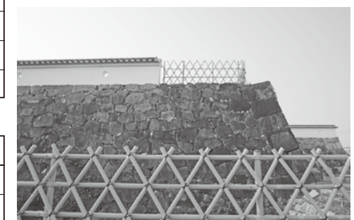
上下写真)整備済みの西側石垣と築地堀
