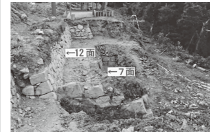
写真2 東虎口12面の検出状況 (5・7面の裏側から検出)
