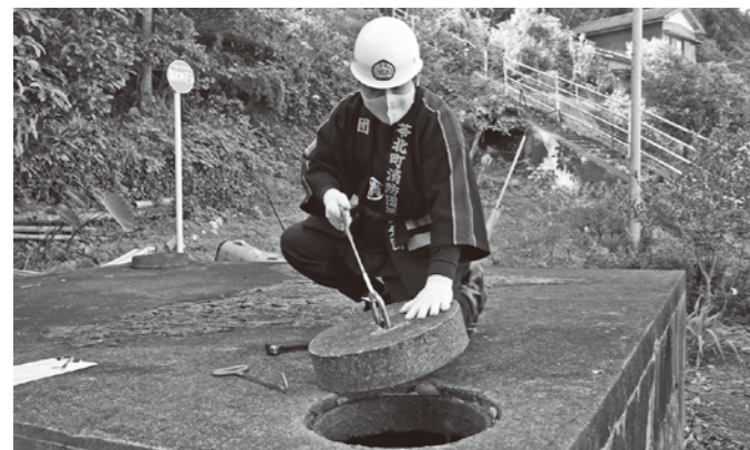
防火水槽のマンホールを開けて水量を確認する消防団員
