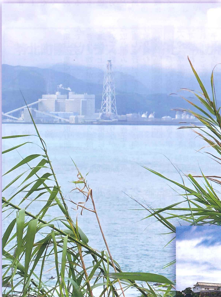
九州電力苓北火力発電所
