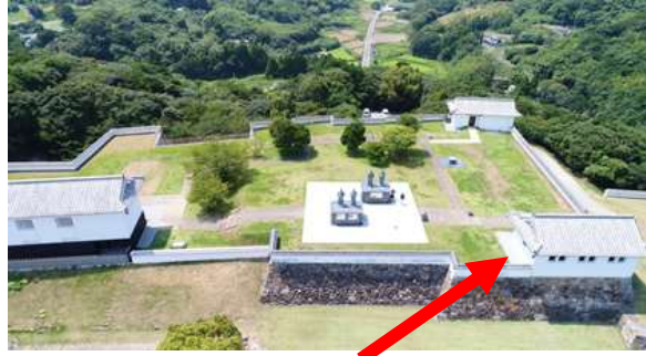
ワーキングスペース富岡城東角櫓 (二の丸：空撮)
