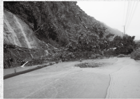
国道389号線の土砂崩れ (H27.6.11撮影)
