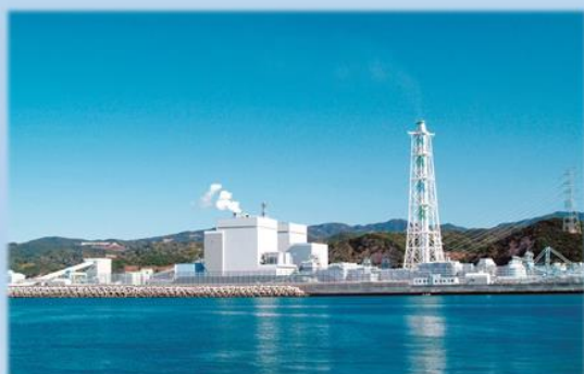
苓北発電所 出典)九州電力HP
