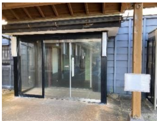
物産館施設（その1）
