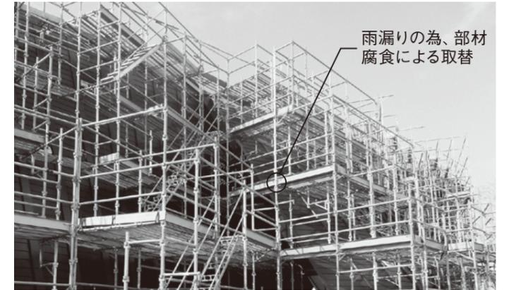
雨漏りの為、部材腐食による取替
