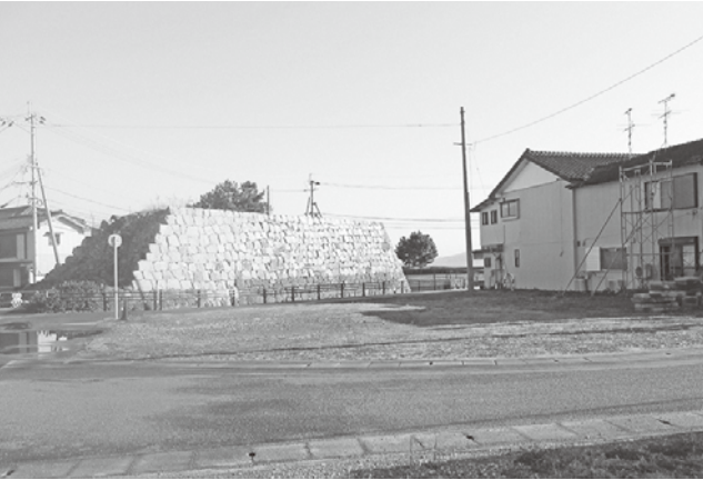
富岡城新大手門現況
