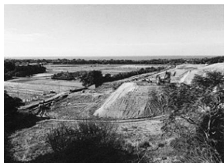
拠点避難地の造成工事状況
