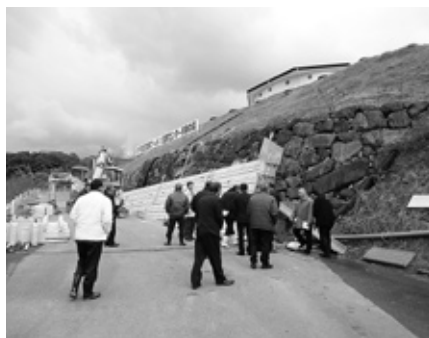
苓北町温泉センター法面復旧工事
