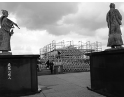
富岡城二の丸長屋（資料館）整備工事
