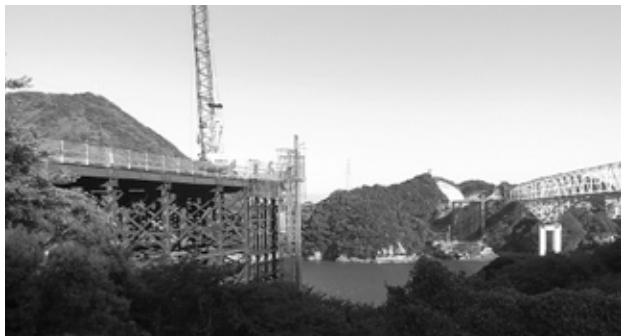
1号橋建設状況
