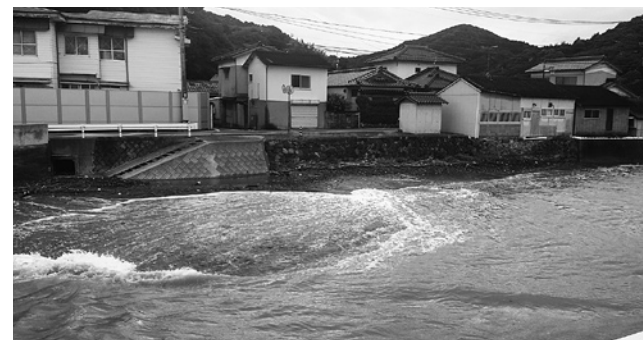
坂瀬川新松原川右岸付近の状況
