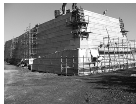
紺屋町避難所建設状況(平成24年3月頃)
