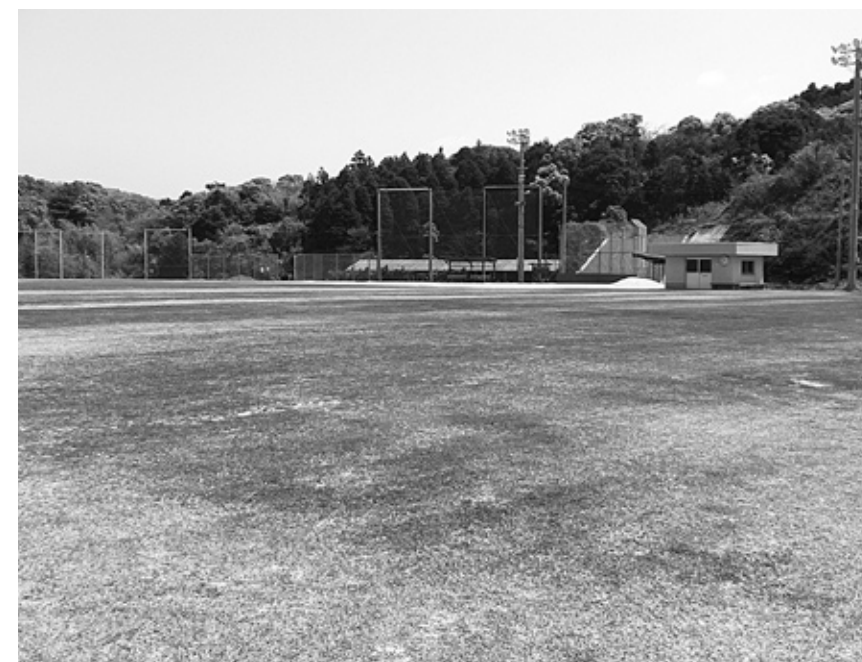
完成した坂瀬川グラウンド
