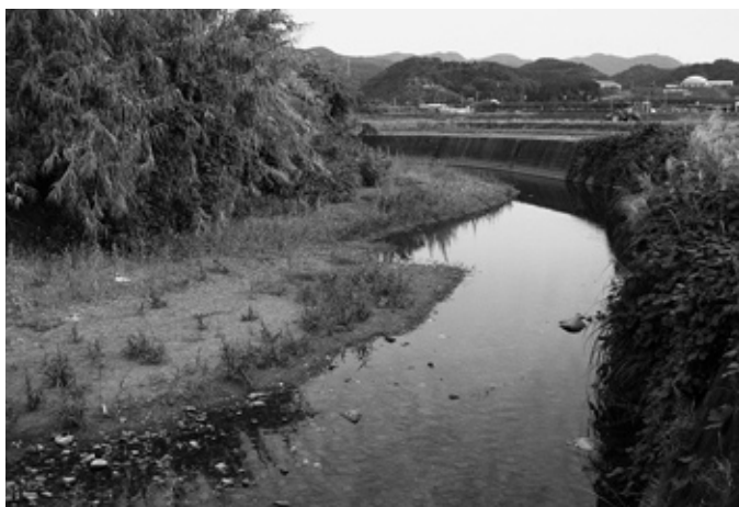
志岐川(堆積している土砂)
