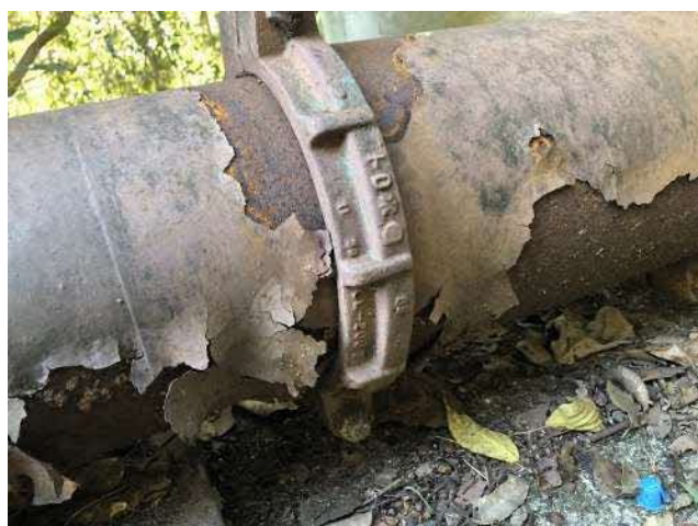
【 老朽化した水管橋 】
